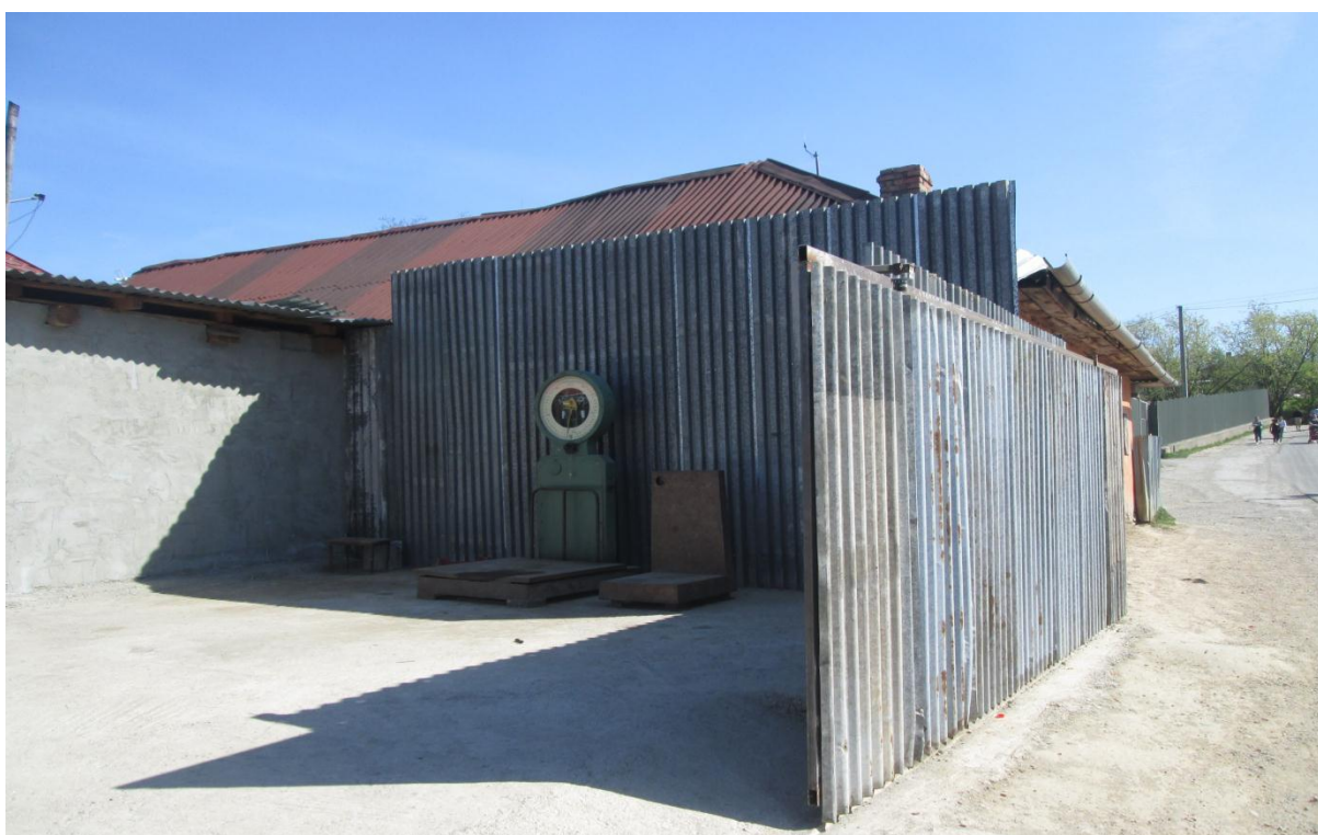
Obr.č.14 - plocha budúceho zariadenia na zber a výkup odpadov s váhami – Jarovnice 106
